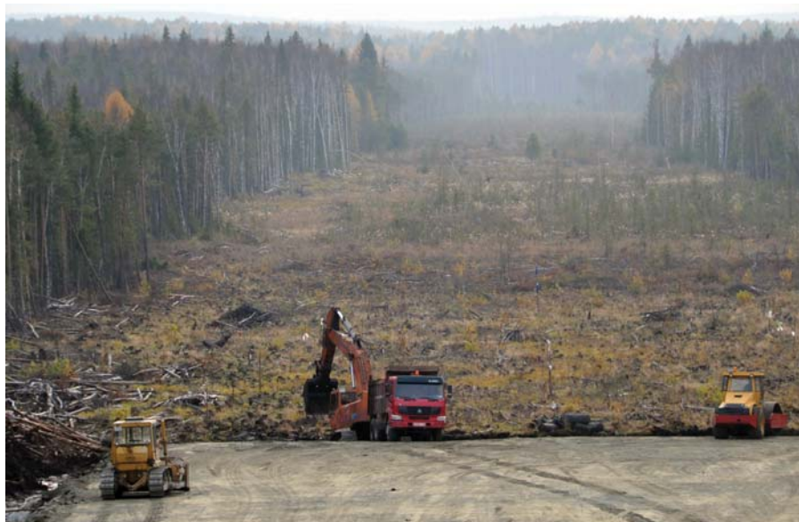
Строительство дороги. Фото Алексея Кунилова
